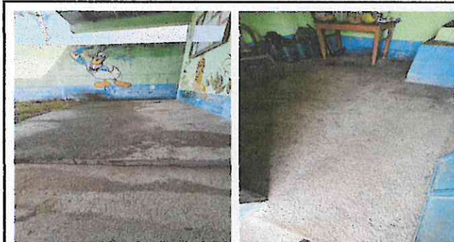
Foto 3: Sustitución de piso de concreto por piso cerámico antideslizante, dentro de la cocina y corredor de la cocina.
