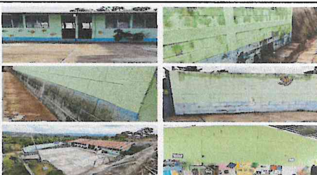
Foto 4: Aplicación de pintura en aulas, cocina, muro perimetral, baños y cancha polideportiva.
