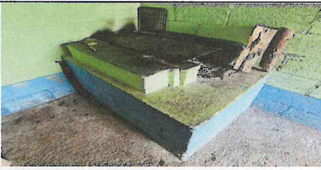
Foto 6: Reparación área de cocina, implementación de azulejo en estufa rural.
