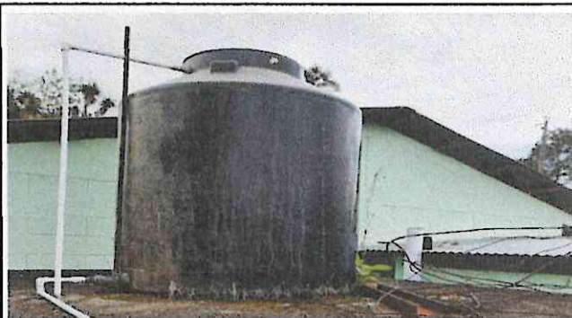
Foto 10: Sustitución de depósito de agua por depósito de agua de 1000 litros.
