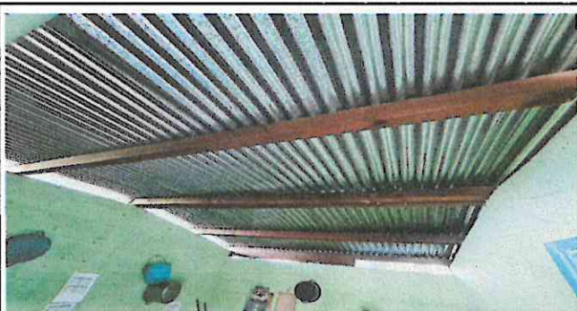
Foto 9: Cambio de estructura de madera por estructura metálica en el techo de la cocina.
