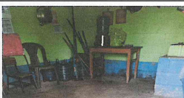
Foto 8: Reparación de repello en paredes internas de la cocina.
