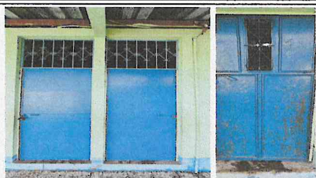
Foto 2: Mantenimiento a puertas de metal, lijado y aplicación de pintura. Salones, cocina y baños.
