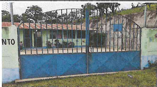
Foto 7: Mantenimiento a portón de metal, lijado y aplicación de pintura.
